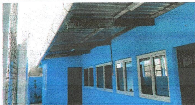
Foto 2: Culmunación de colocado de ventanas
