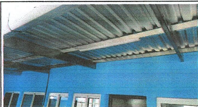
Foto 3: Culminación de cambio de techo.
