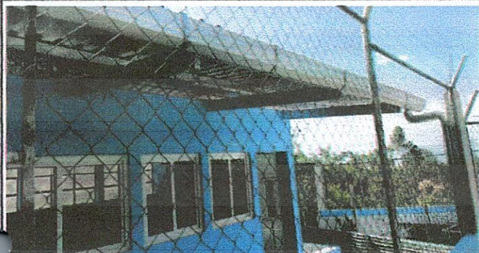
Foto1: Culminación de colocado de canal
